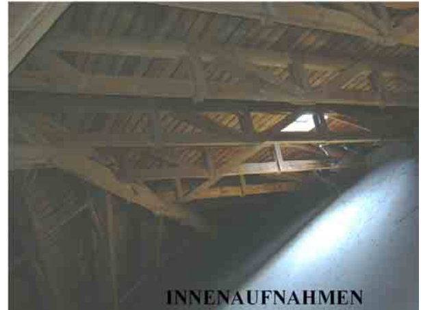
Abbildung 9 und Abbildung 10: Innenaufnahmen des Dachbodens – sichtbar ist die Dachtragkonstruktion und die oberste Geschossdecke
