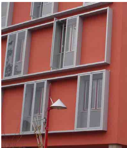
Abbildung 22: Detailaufnahme Fassade „Kastenfenstersystem - neu“, Quelle: LIG Steiermark
