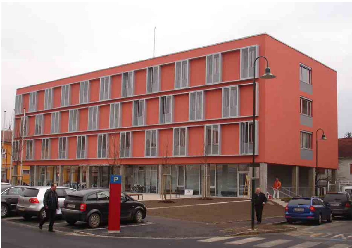
Abbildung 24: Ansicht Westfassade mit Haupteingang nach der Sanierung, Quelle: LIG Steiermark
