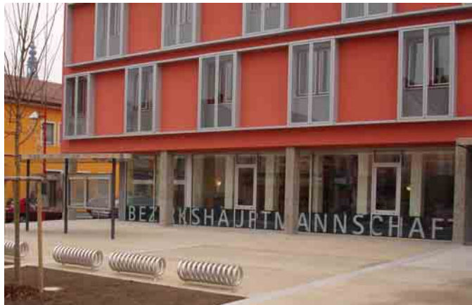
Abbildung 18: Vorgesetzte Pfosten-Riegelfassade im Erdgeschoss (Westfassade Haupteingang), Quelle: LIG Steiermark
