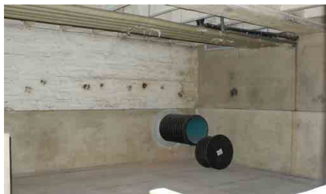
Abbildung 28: Einmündung des Erdkollektors im Keller
