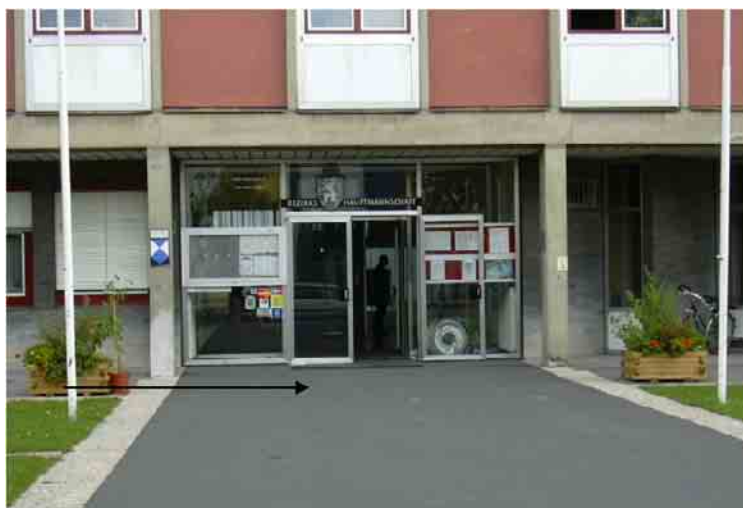
Abbildung 8: Haupteingang Fassade West (Zugang Realschulstraße) – Alu-Fenster im EG
