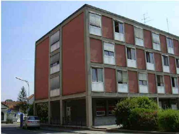
Abbildung 2, Abbildung 3: Fassadenecke Nordwest, Fassadenecke Südwest; Stahlbetonskelett mit Fensterelementen, zurückversetztes Erdgeschoss, Sonnenschutz durch außen liegende Jalousien
