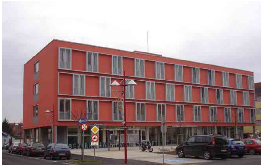
Abbildung 15: Das Gebäude nach der Sanierung, Ansicht Westfassade, Haupteingang Realschulstrasse
