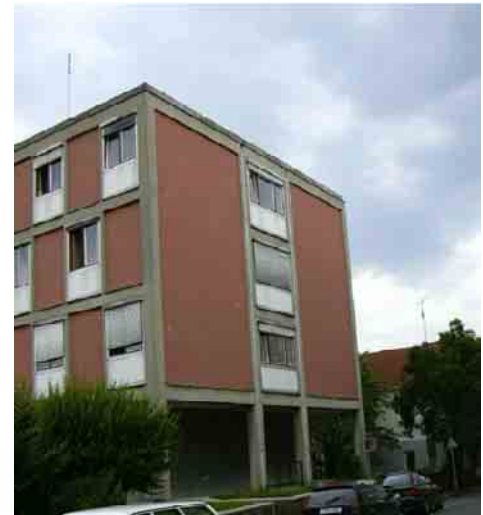
Abbildung 2, Abbildung 3: Fassadenecke Nordwest, Fassadenecke Südwest; Stahlbetonskelett mit Fensterelementen, zurückversetztes Erdgeschoss, Sonnenschutz durch außen liegende Jalousien
