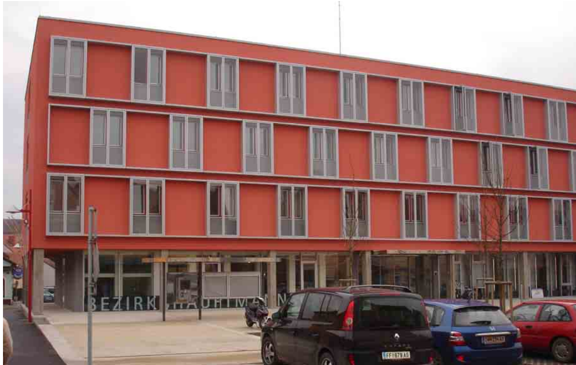
Abbildung 25: Ansicht Westfassade mit Haupteingang nach der Sanierung, Quelle: LIG Steiermark
