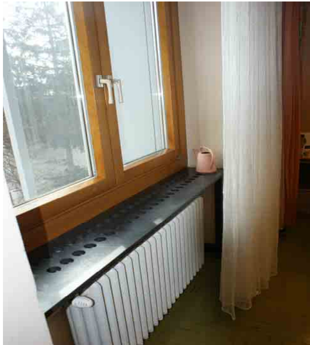
Abbildung 12: Rippenheizkörper in den Büroräumen
